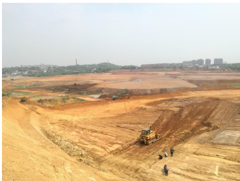
图 14：土石方工程现场进度（4 月 20 日摄）
