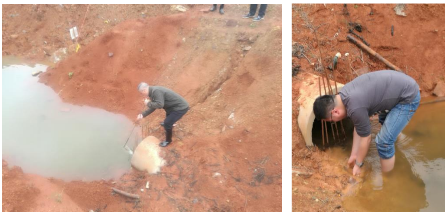
图 15：基建处处长王新初、工程部朱闻冬巡查中清理排水进口（4 月 23 日）
