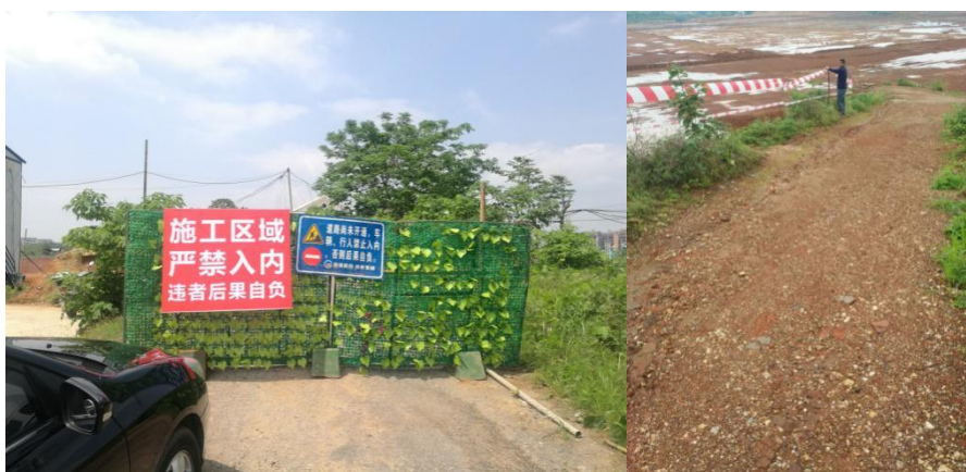
图 18、图 19：施工现场道路封堵、警示带设置
