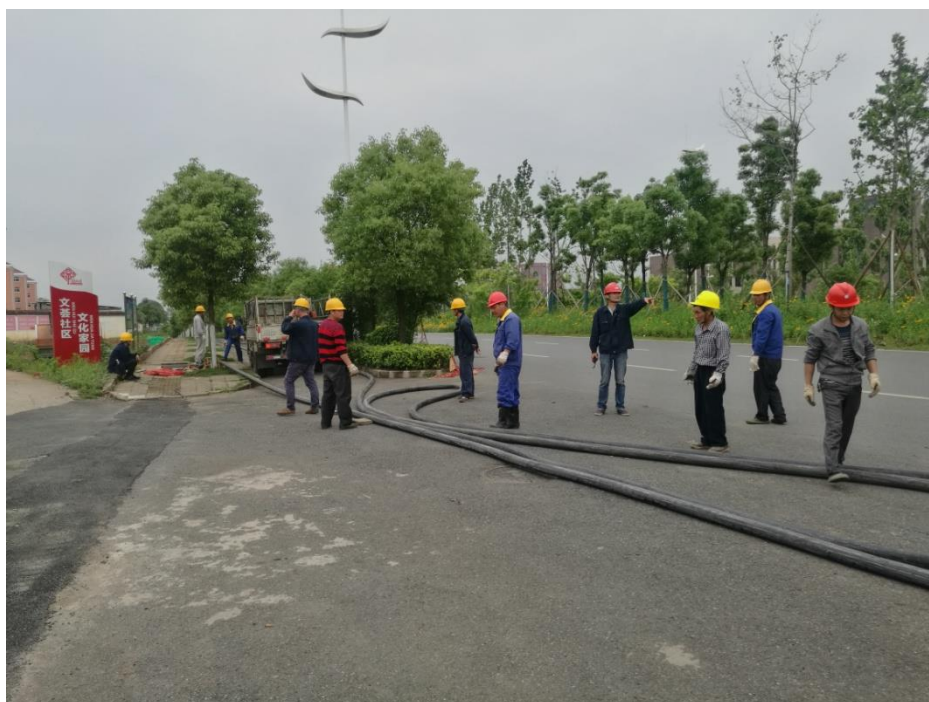
图 20：高压电缆敷设中
