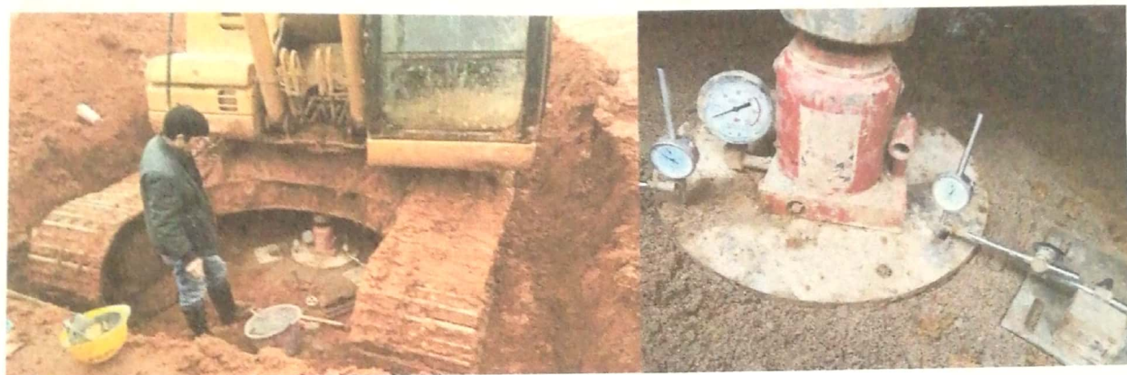
地基承载力荷载板试验
