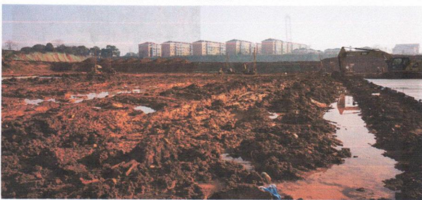
宿舍楼超前钻现场
