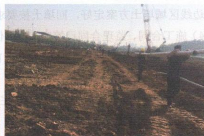
临时水、电施工中
