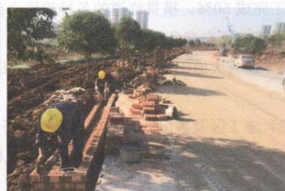
临时道路、洗车池、临时排水沟
