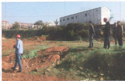
防尘网面积现场确认
