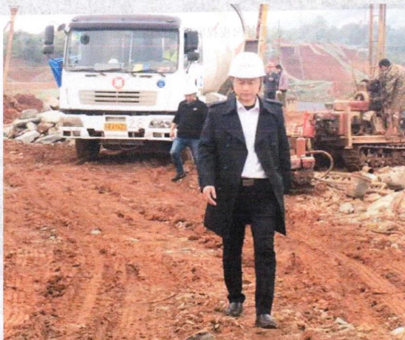
代建单位领导检查施工现场
