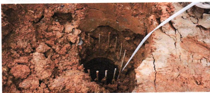
浇灌完成后，桩砿下沉
