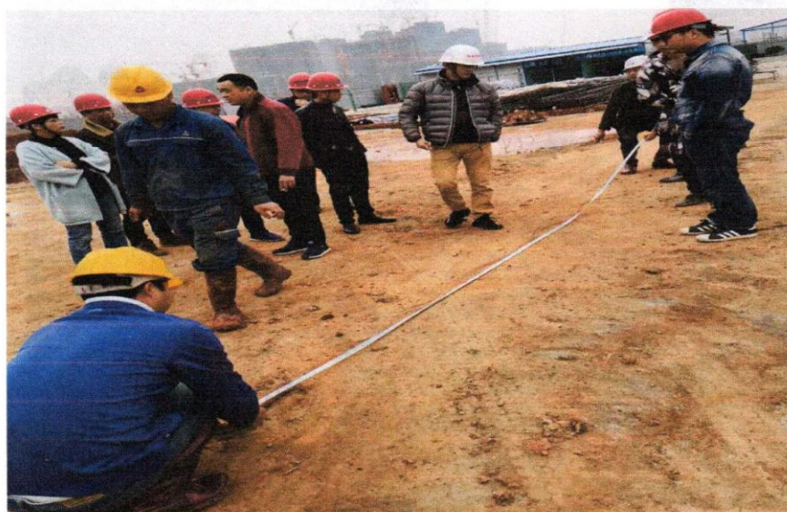
参建各方一起检查桩成孔的各项技术经济指标
