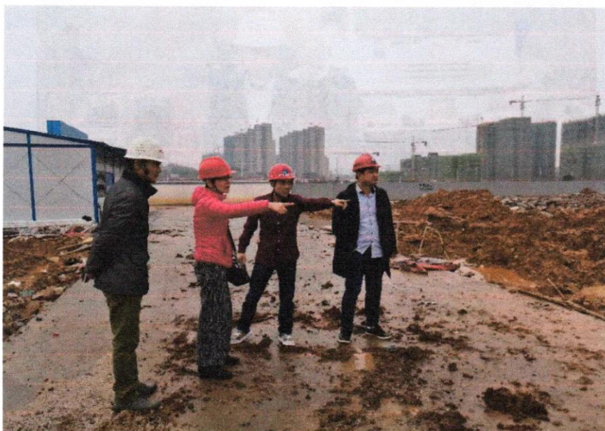
校领导周末视察施工现场
