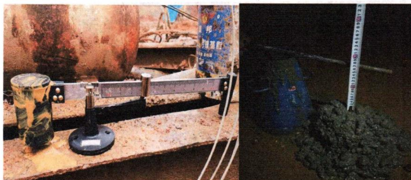
冲孔灌注桩全过程控制
