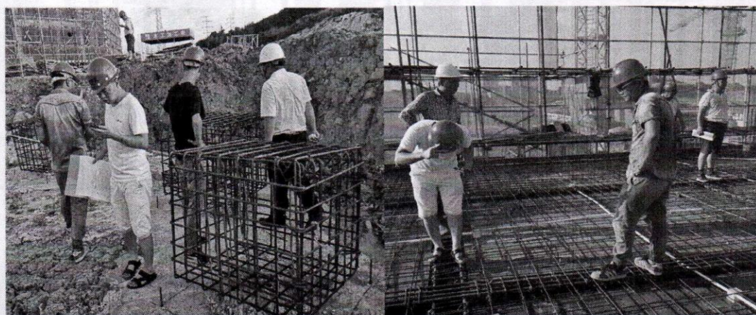
施工现场检查工程质量
