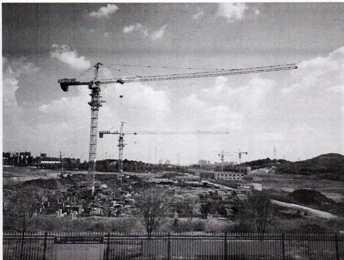
省五学生宿舍施工现场
