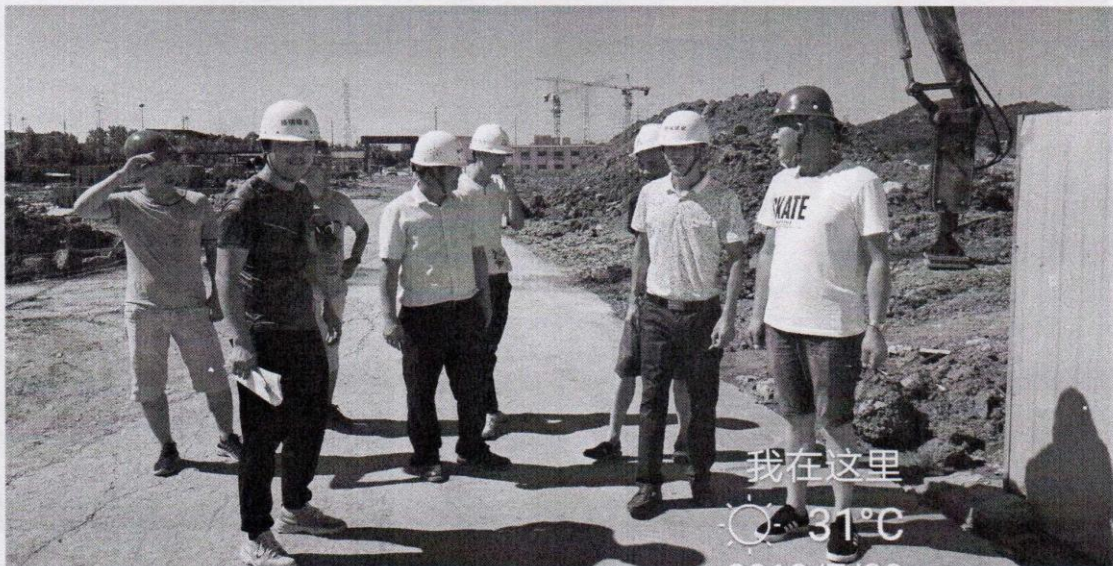
质量、安全、文明施工大检查
