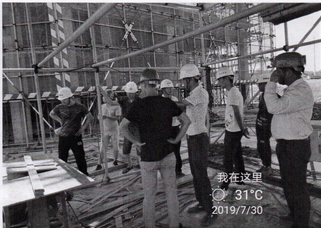
施工现场检查安全、文明施工
