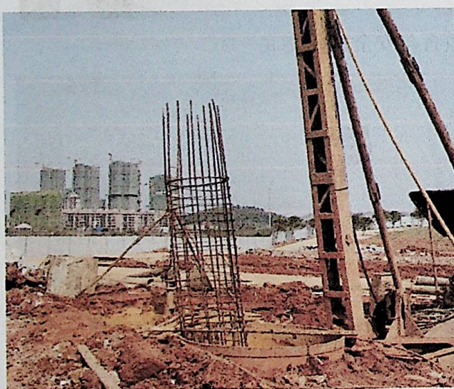
桩钢筋笼安装
