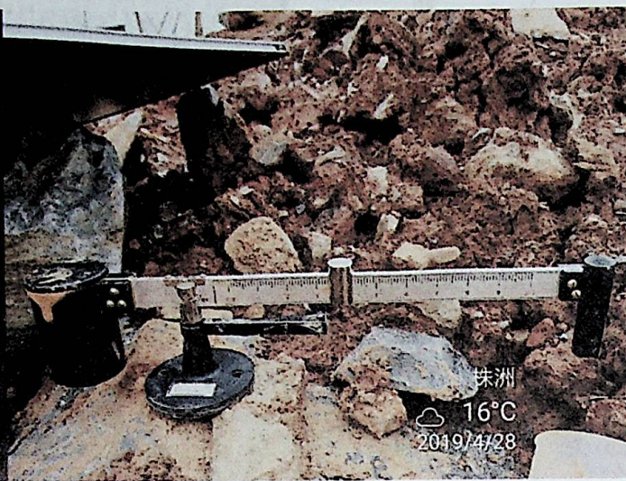
实测泥浆比重
