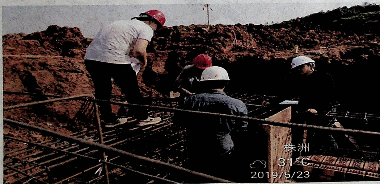
基建处现场负责人黄福安组织参建各方实测实量钢筋笼
