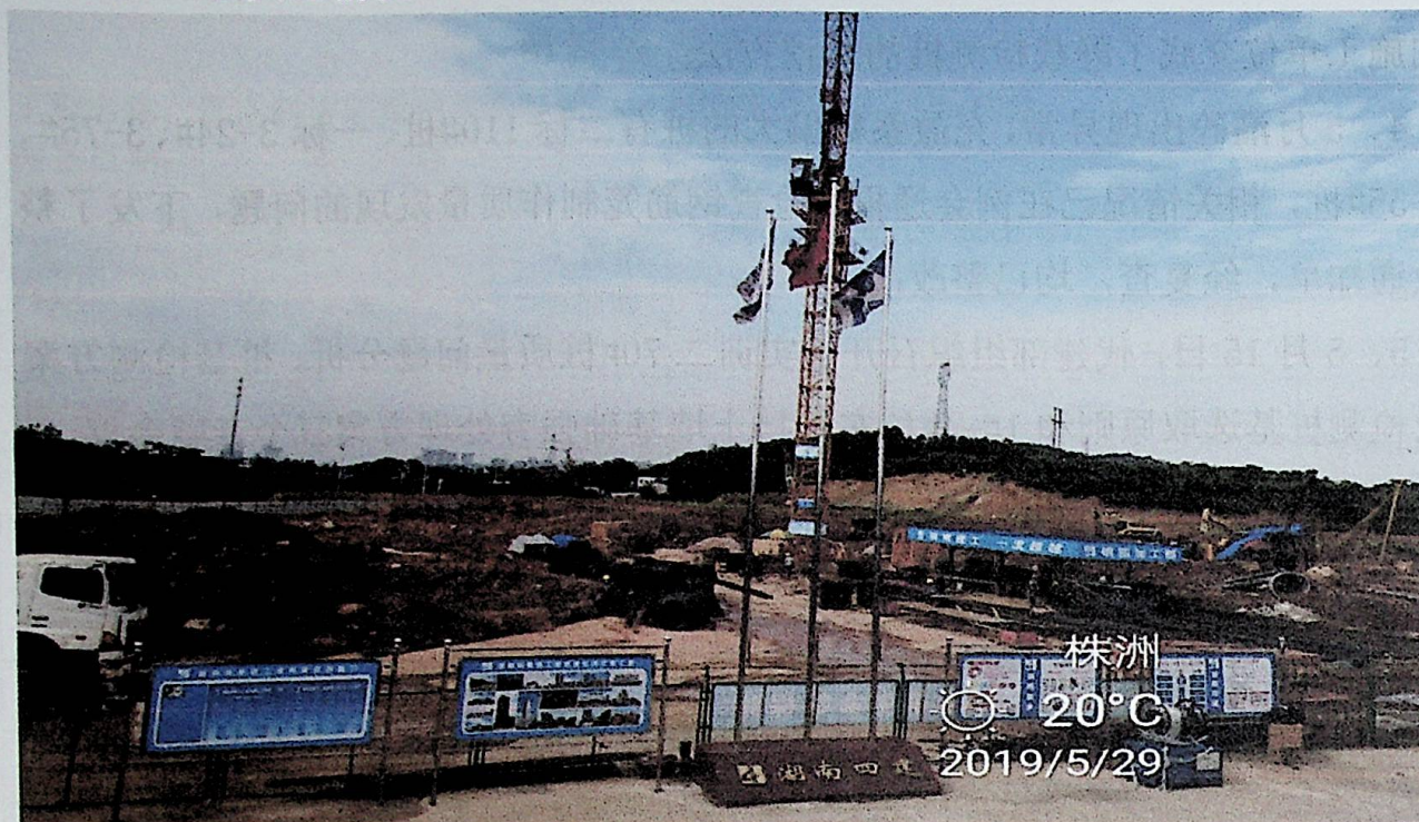
省四：实训中心二施工现场
