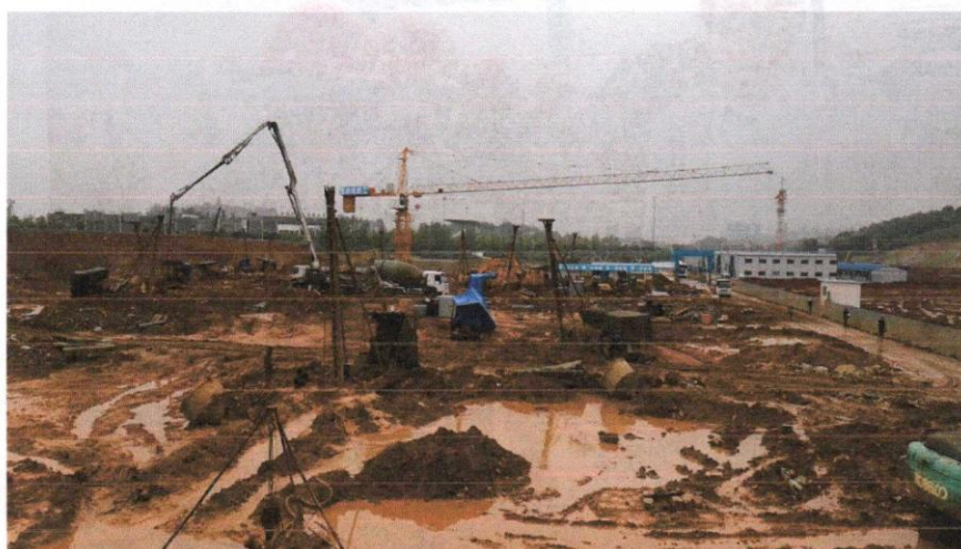
二标省五施工现场
