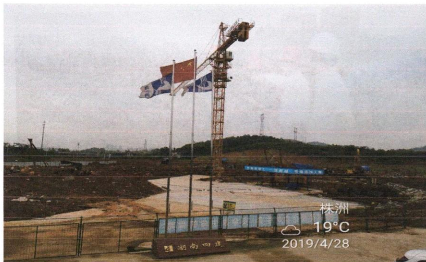
一标省四施工现场
