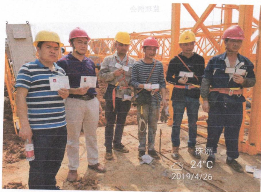
塔吊安装特种作业人员人证相符、人证相符
