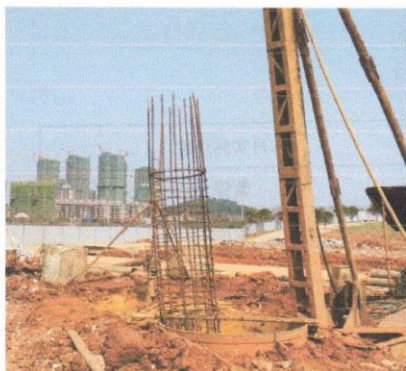
桩钢筋笼安装
