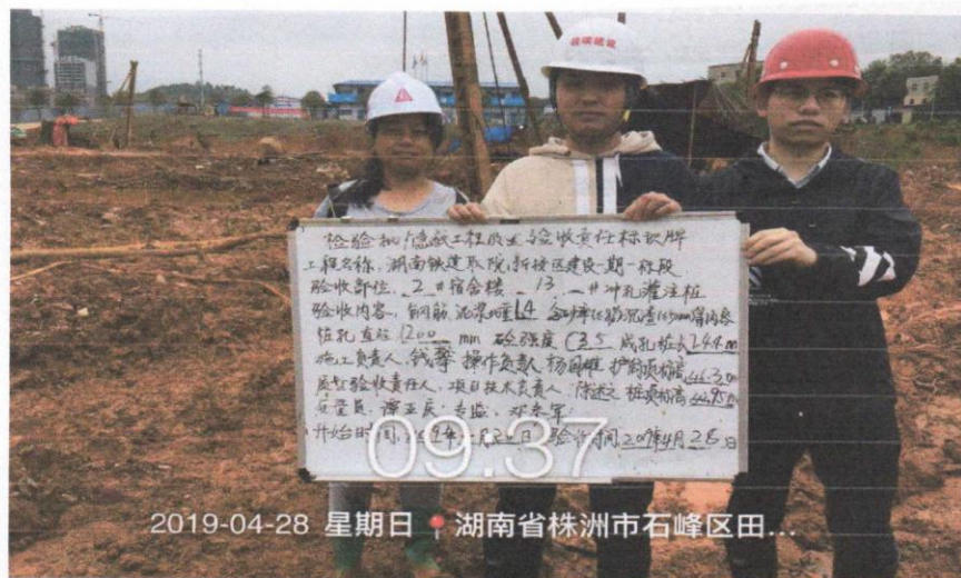
冲孔灌注桩成孔验收
