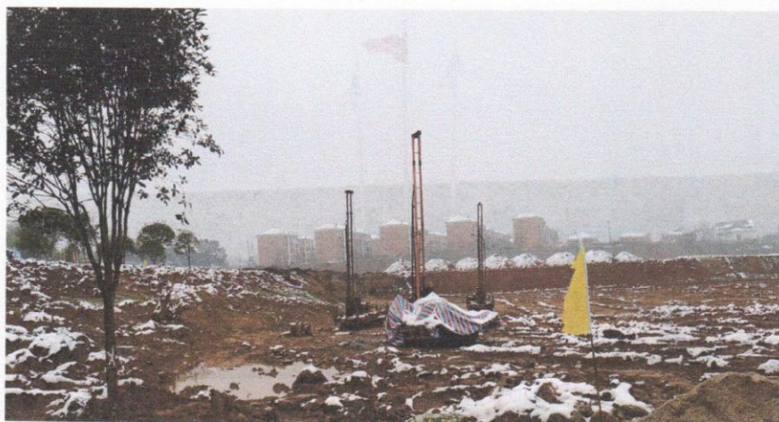
施工现场—超前钻
