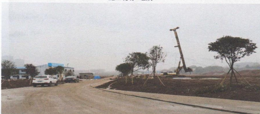
施工现场—桩基旋转钻
