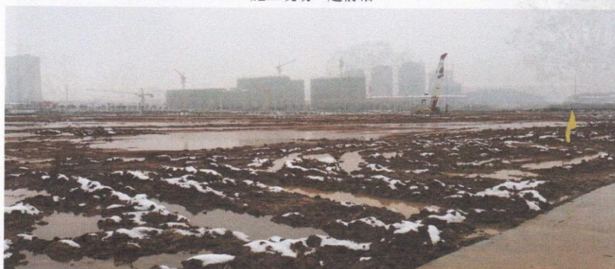
施工现场—强夯
