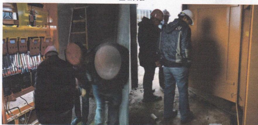
安全周检查—检查临时配电房
