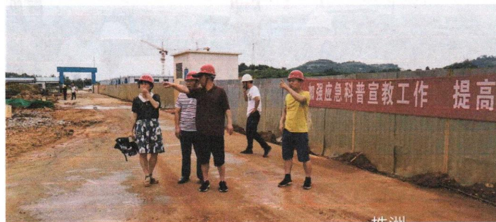
学校领导施工现场检查指导工作
