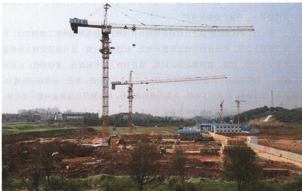
一标学生宿舍省五施工现场
