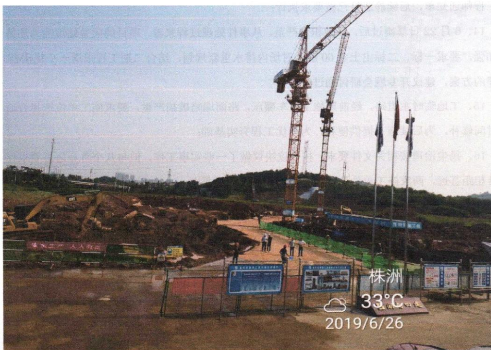
二标实训中心二省四施工现场
