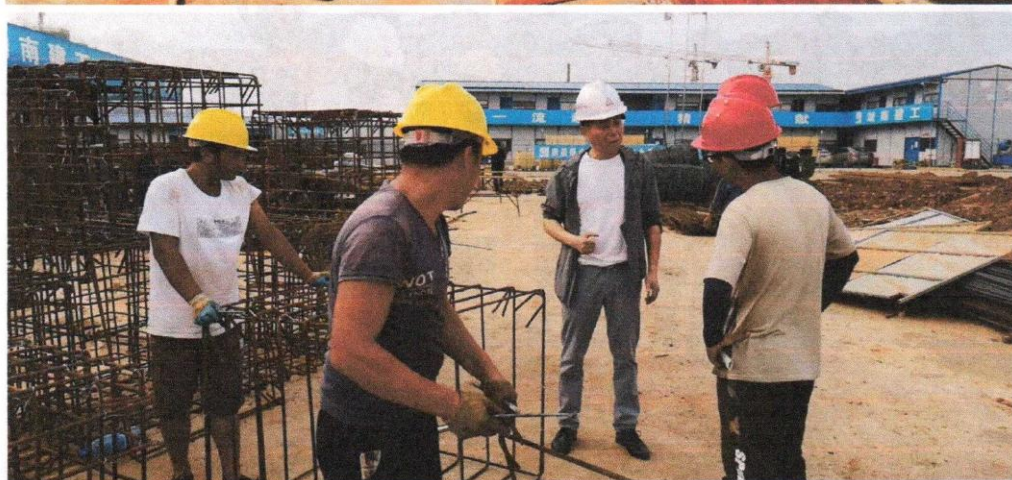
南方监理领导施工现场检查指导工作
